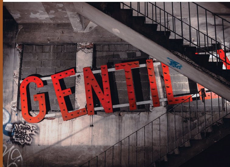
Le Lavoir avant travaux © Gilberto Gúiza Rojas
